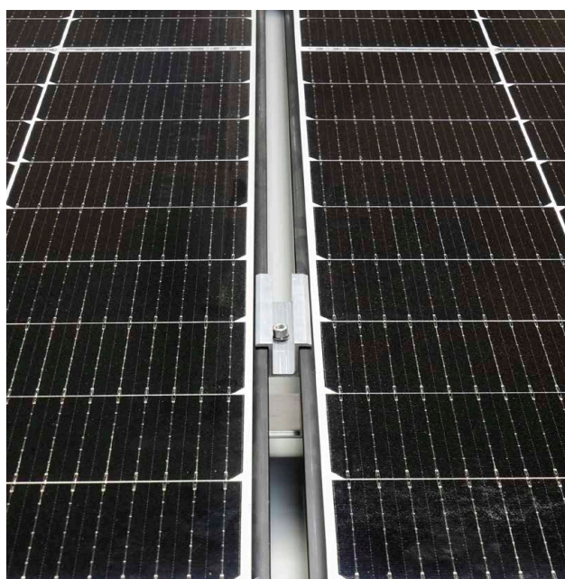
Middenklem voor platte daken
